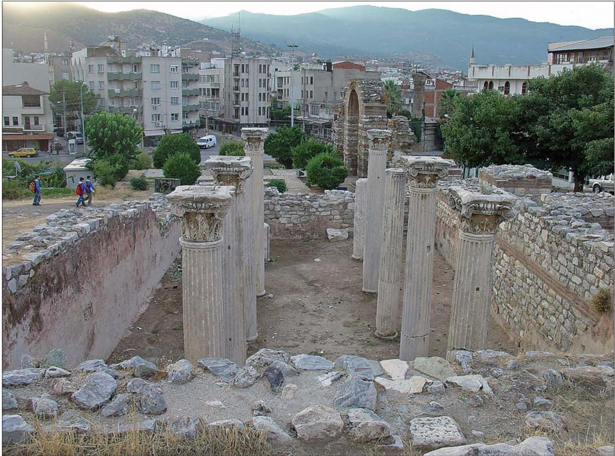
**Abb. 18** Byzantinische Aquäduktbrücke von Selçuk. Wasserreservoir am Ende der Brücke mit Spoliensäulen aus dem 2. Jahrhundert.
