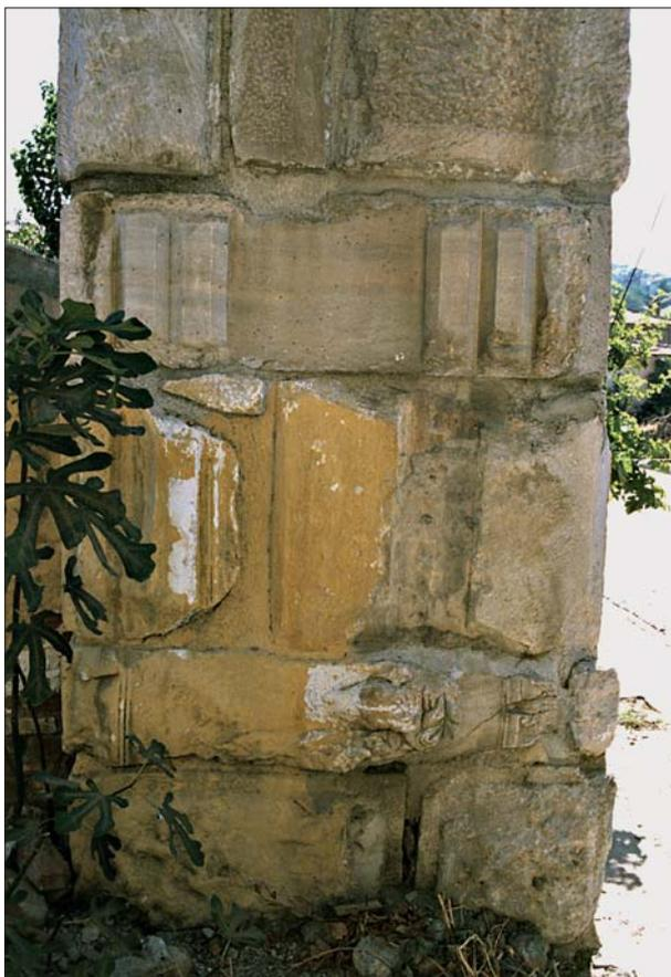
**Abb. 14** Byzantinische Aquäduktbrücke von Selçuk. Beispiel für die Verwendung von Spolien an Pfeiler 32.
