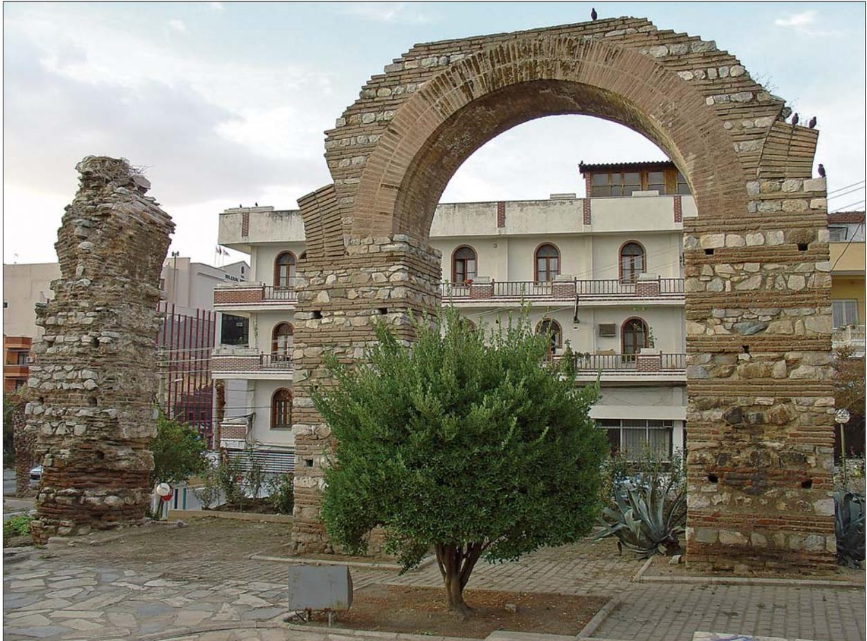
**Abb. 16** Byzantinische Aquäduktbrücke von Selçuk. Reine Mauerwerkspfeiler 114-116 ohne Spolienblöcke.
