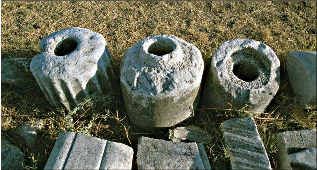
**Abb. 17** Byzantinische Aquäduktbrücke von Selçuk. Steinrohre der Druckleitung im Bereich der Johannesbasilika.
